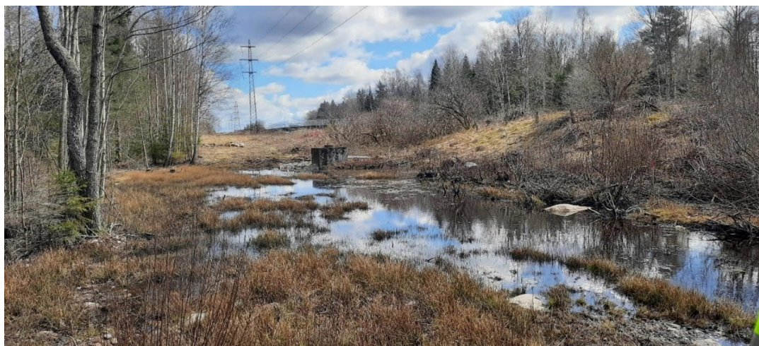
Figur 7: Våtmark och dike i öster med brunn för flödesregulator.
