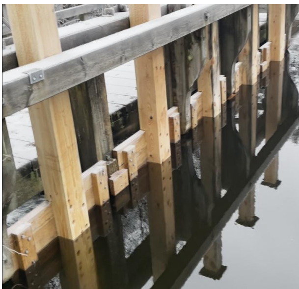
Figur 2. Fotografering av renoverade spetluckor vid Vartorps dammanläggning.
