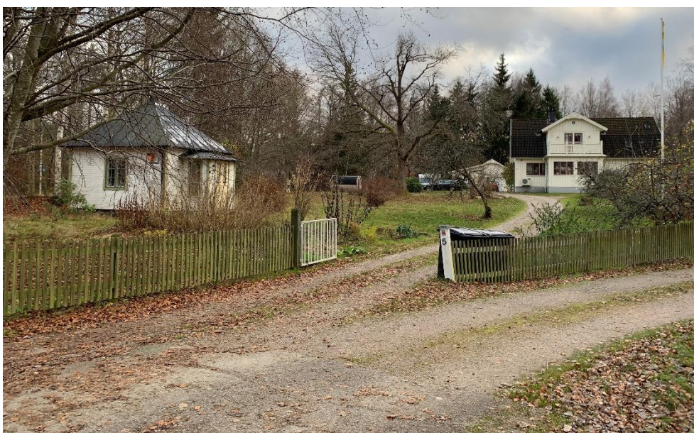
Det första huset beläget längs Hagaviksvägen mot söder utgörs av en stor tomt med staket i fastighetsgräns. Bebyggelsen utgörs av en ljus färgskala vilket märker ut sig i den annars relativt enhetliga färgskalan med röda fasader. Lusthuset är troligen från sekelskiftet medan huvudbyggnaden är senare byggd.
