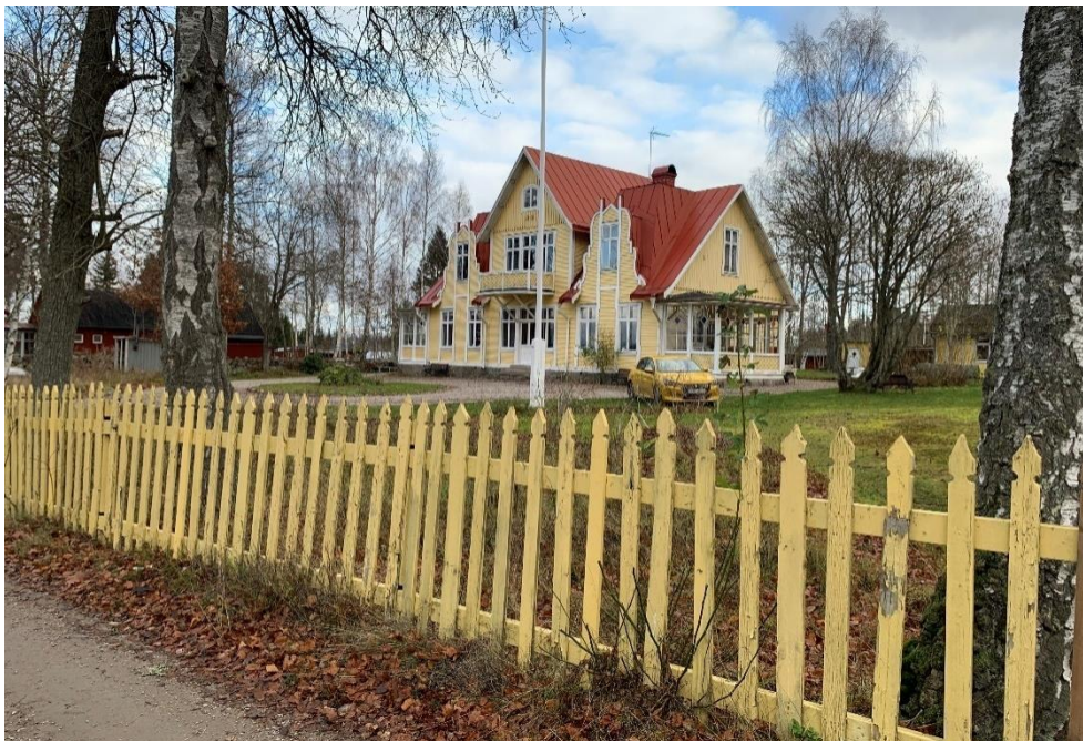
Björkvik eller Nordmarkska villan, uppförd i nationalromantisk karaktär, har en generös tomt som omgärdas av ett gult trästaket troligen från uppförande 1901. På flera tomter i området har staketet samma kulör som huvudbyggnadens fasad.
