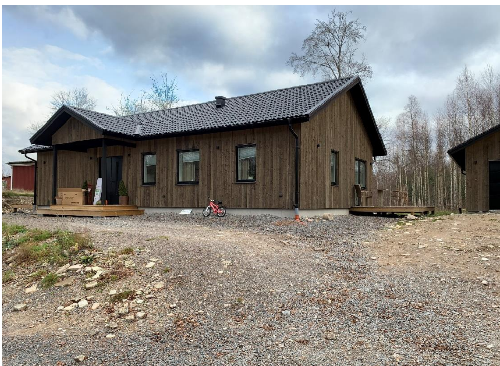
I områdets södra del finns en nyligen tillkommen modern villa som avviker från befintlig bebyggelse i terränganpassning och fasadkulör men knyter an till områdets karaktär vad gäller fasadmateriäl och sadeltak.
