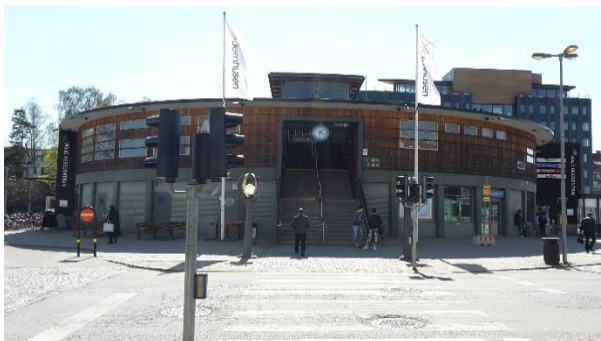
2016: Tävlingsområde från norr. Befintligt resecentrum som kommer att rivas.
