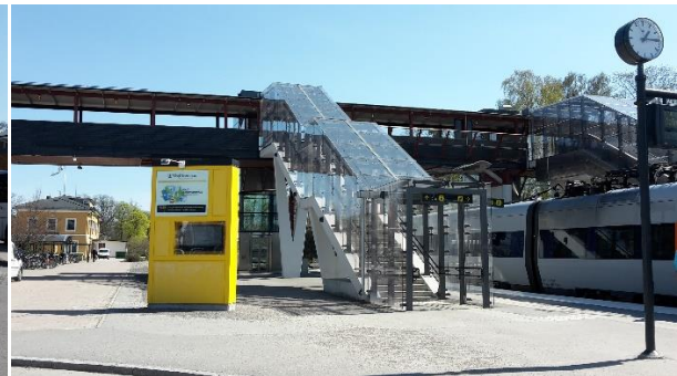
2016: Del av gång- och cykelbro från väst
