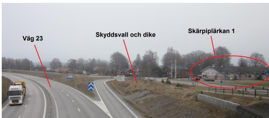
Figur 2.2. Bild över aktuell fastighet, väg 23 och skyddsvallens placering.
