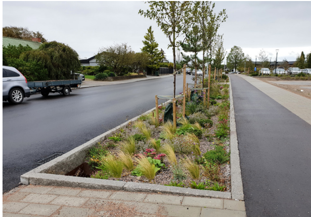
▲ Regnbäddar och hårdgjorda ytor på ett stråk av öppet förstärkningslager. Campusområdet, Vellinge.
