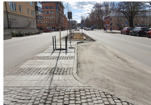
Parkering, träd i hårdgjord yta och regnbädd på ett stråk av öppet förstärkningslager. Strandbogatan, Uppsala.
