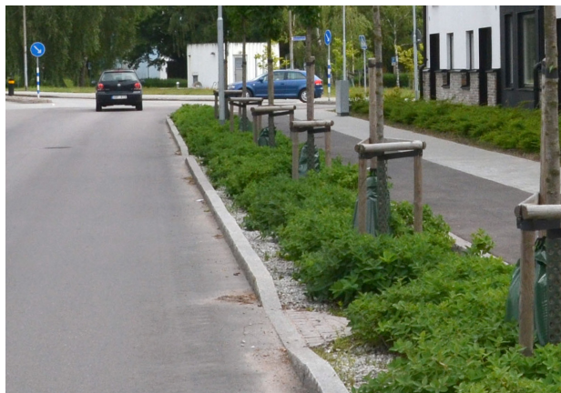
Smal och grund regnbädd samt gc-yta på öppet förstärkningslager. Perstorpsgratan, Vellinge.
