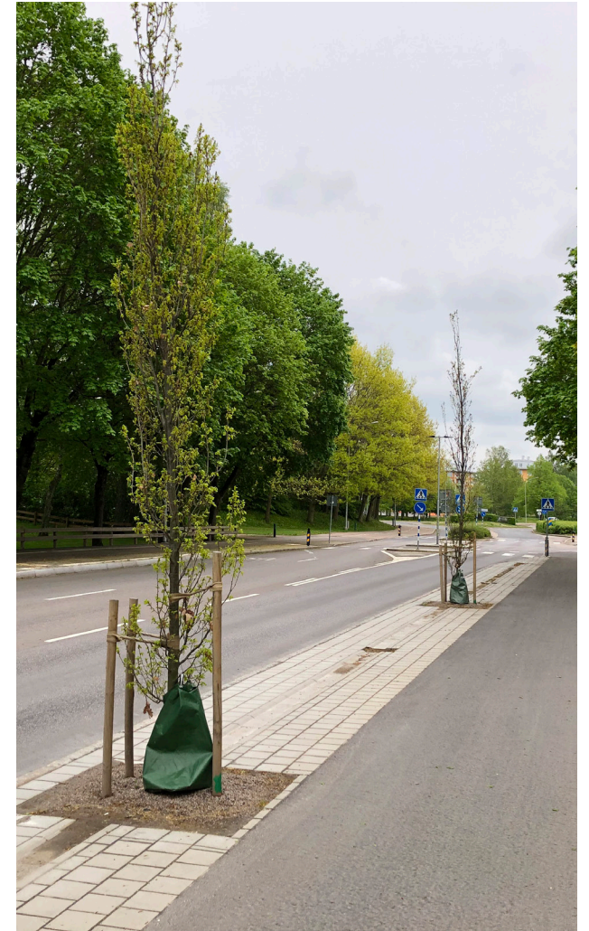
▲ Träd i hårdgjord yta på stråk av öppet förstärkningslager. Liedbergsgatan, Växjö.
