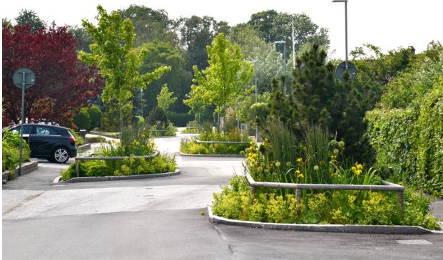
▲ Enskilda regnbäddar på öppet förstärkningslager. Rundelsgatan, Vellinge.
