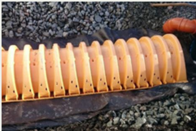
▲ Dagvattentunnlar under anläggningsskedet som ansluts till styrningsbrunnen. Den vävda geotextilen hindrar att sediment når det öppna förstärkningsmaterialet.
