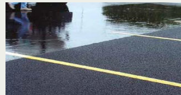
Tät / dränerande hårdgjord yta av asfalt.
