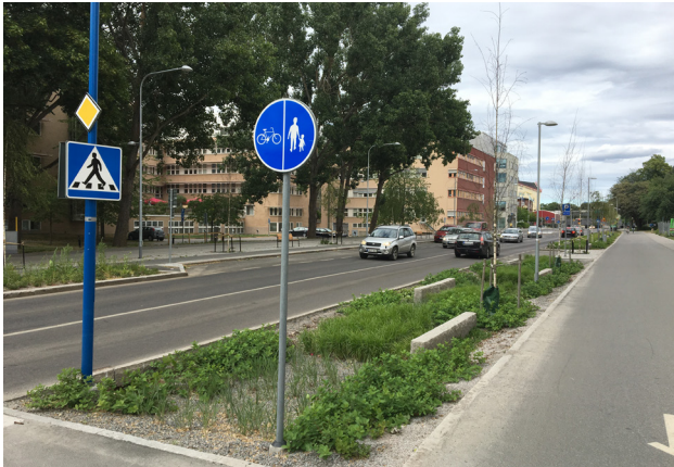
▲ Regnbädd på stråk av öppet förstärkningslager. Strandbogatan, Uppsala.
