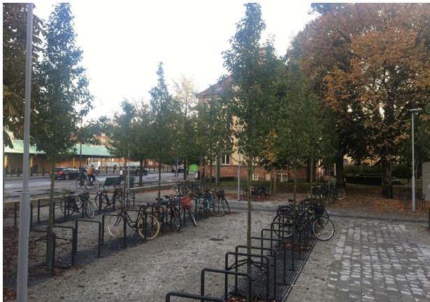
▲ Cykelparkering med dränerande beläggning på öppen överbyggnad, som utgör magasin för dagvatten och växtbädd. Södervärn, Malmö.
