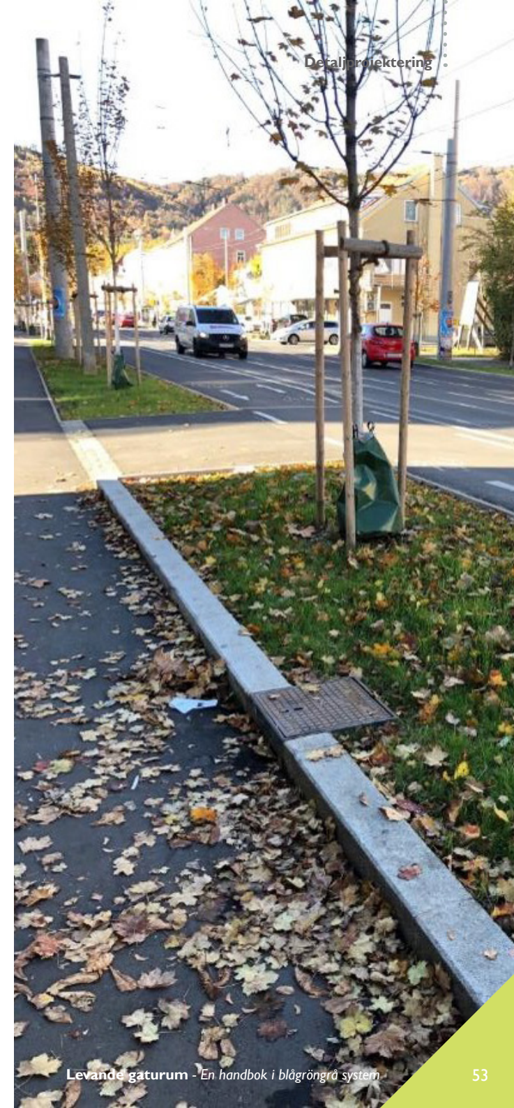
Figur 31. Vegetationsyta på öppet förstärkningslager med generellt lägre krav. Kan även utföras som perenn- och buskplantering.
