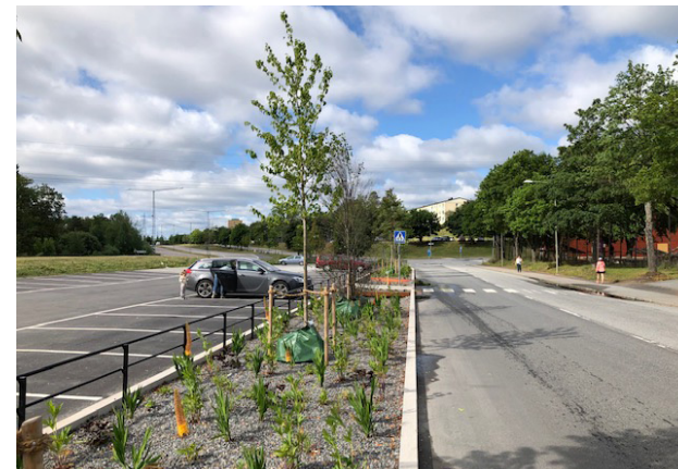
Vegetationsyta på ett stråk av öppet förstärkningslager. Eksätravägen, Stockholm.
