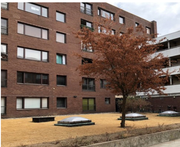
Stadsträd och gräsyta på kvartersmark under stor torkstress, Malmö.
