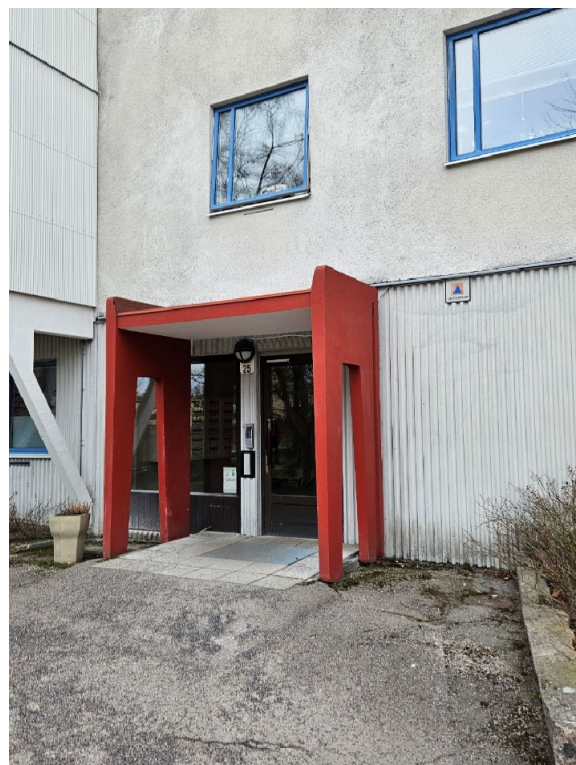
Entréportal i betong
