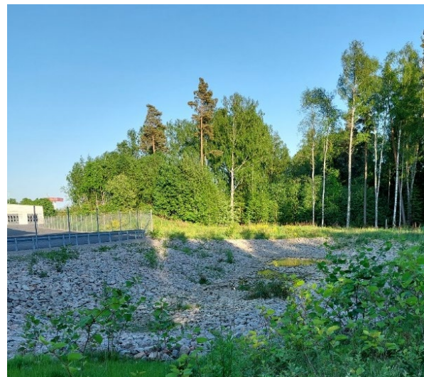
Bild 1: Nyanlagd fördröjningsdamm i södra delen av planområdet.
