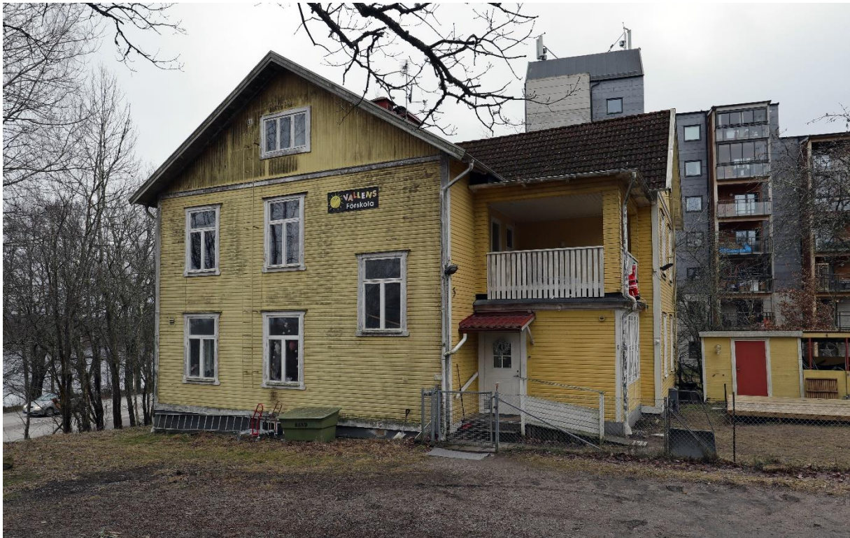
Närheten till Söderleden tydliggörs här. Fasaderna är smutsiga och drabbade av allehanda påväxter men direkta virkesskador synes inte förekomma
