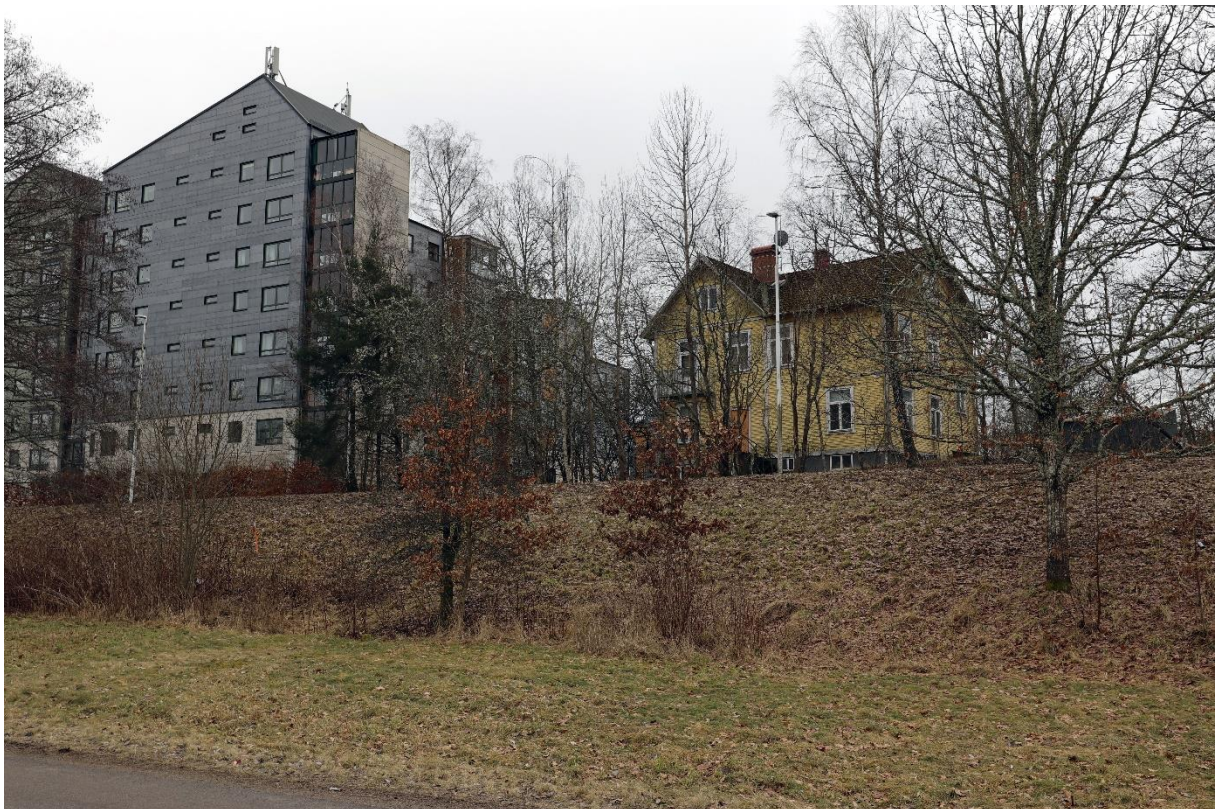
Foto taget från cykelbanan utmed Växjösjön. Byggnaden har alltid haft en iögonfallande placering. Sedan Söderledens tillblivelse och den förbättrade tillgängligheten kring sjön har den monumentala effekten förstärkts där huset blivit ett välkänt riktmärke. Volymeffekten av de intilliggande flerbostadshusen är påfallande.
