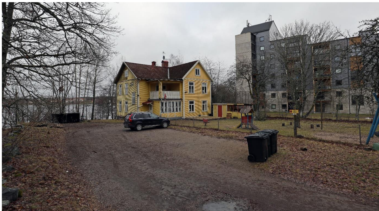
Vårdhemmet från 1912 innehåller idag hyreslägenheter. Trädgården förvandlades på 1990-talet till lekplats. Under 2010-talet uppfördes höga flerbostadshus nära fastighetsgräns.
