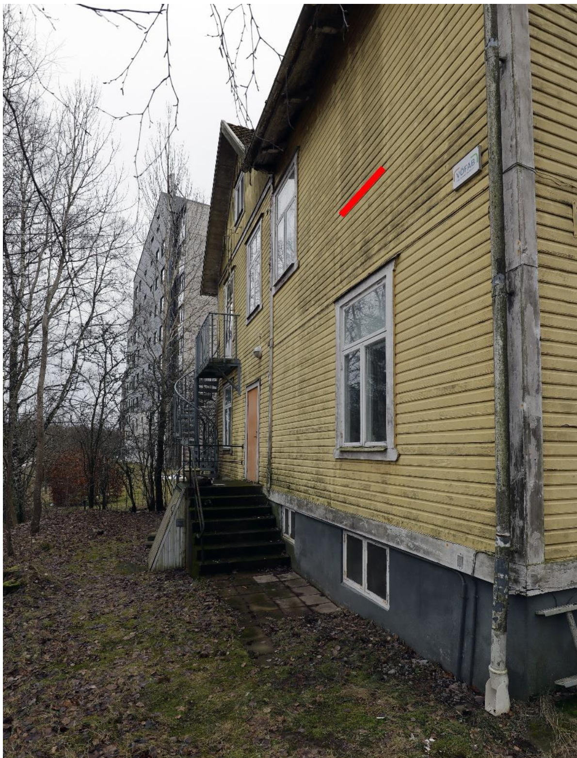
Fasad mot Växjösjön. Igensatt fönster markeras med rött streck. Här syns sidoentrén, nedgången till källaren samt spiralbrandtrappan.
