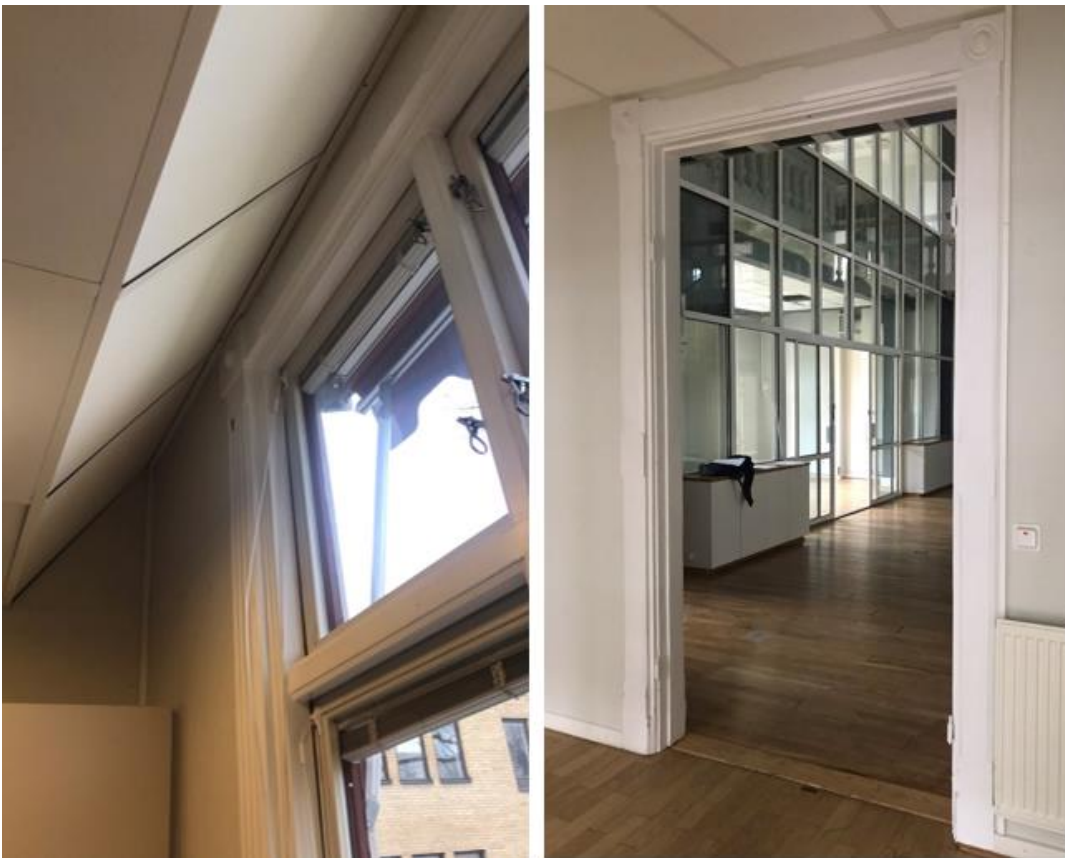
Figur 37 Till vänster en bild som visar de ursprungliga fönsteromfattningarna och att undertaket rests för att spara dessa, till höger en bild som visar de ursprungliga profilerade dörromfattningarna.
