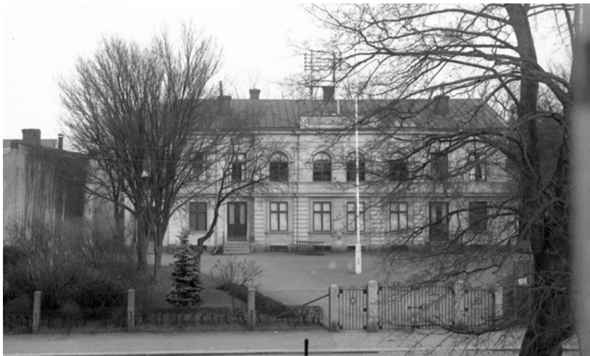
Figur 18 Ordenshuset på 1930-talet. Bakom det vänstra trädet kan man skymta den västra förstugan som kom till 1909. Notera också att det tidigare trästaketet ersatts med ett stängsel och att de smidesgrindar som finns kvar idag också kommit till. Foto: Anton Persson Källa: Kulturparken Småland.
