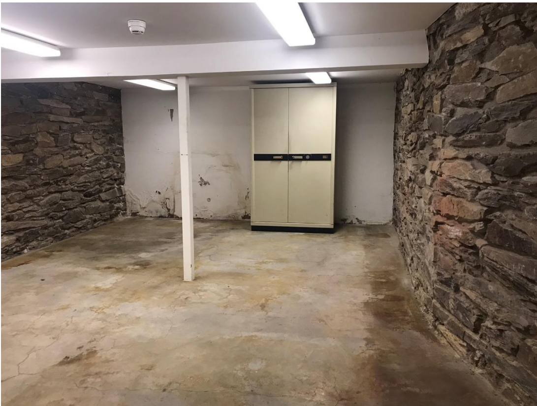
Figur 39 Källaren med ursprungliga källarmurar.
