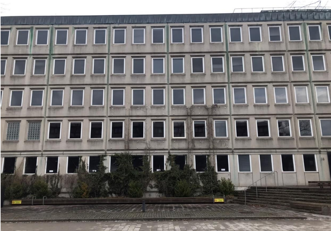
Figur 53 Femvåningshuset mot Västra Esplanaden med fasaden i prefabricerade betongelement, utskiftade fönster och krön i kopparplåt.
