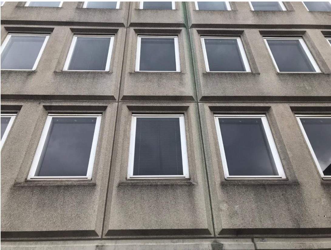
Figur 54 Detalj av femvåningshusets betongelement, notera fasningen mot fönstren och kanterna.
