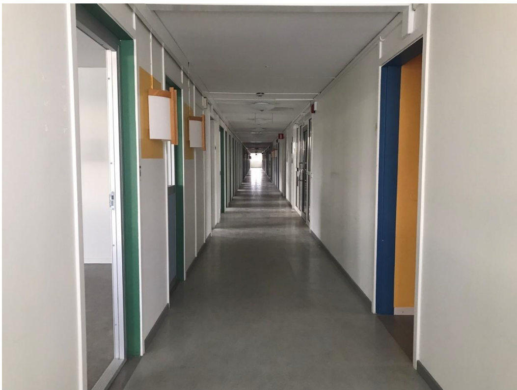
Figur 66 Typisk vy av mittkorridor i femvåningsbyggnaden.
