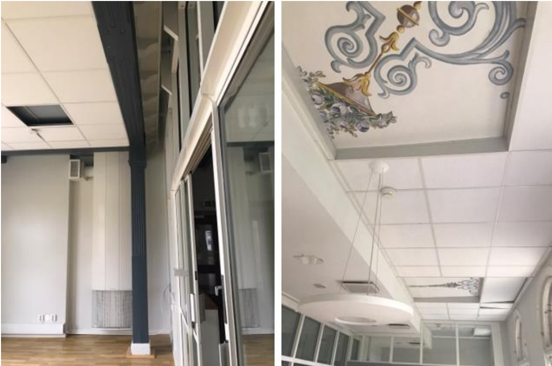
Figur 34 Till vänster en bild som visar hur glaspartiet satts in med viss hänsyn till läktarens konsoler, till höger en bild som visar "titthålen" i undertaket upp mot det ursprungliga innertakets målning.
