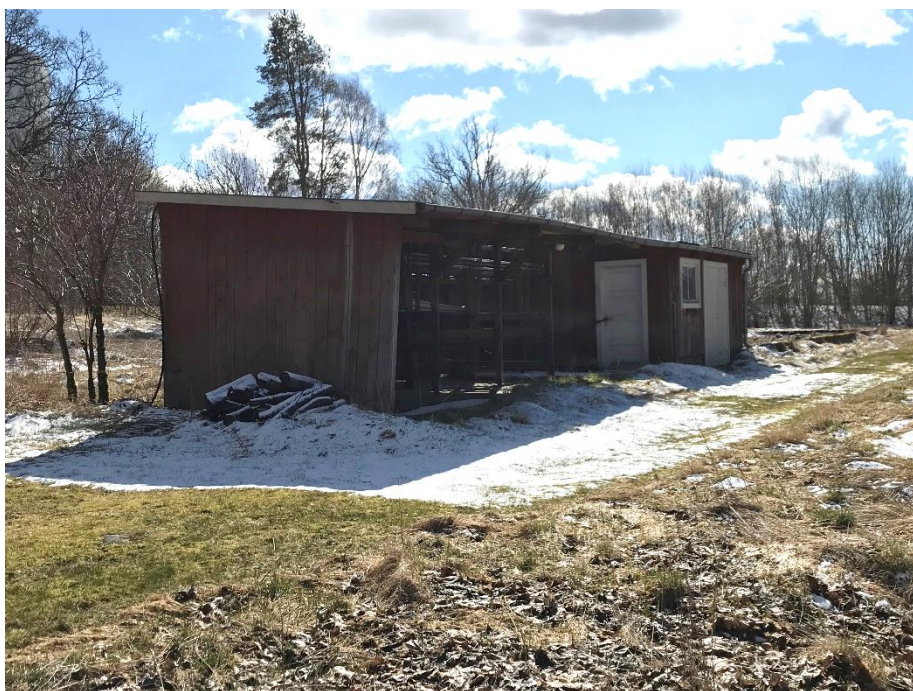
Figur 18 Det lilla skjulet. Till höger i bild bortom skjulet skymtar den tidigare ladugårdens grund.
